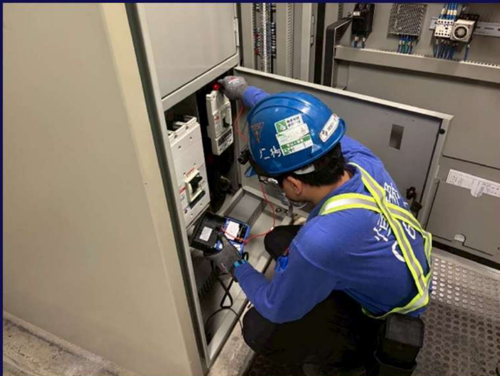
低壓設備絕緣電阻量 測
