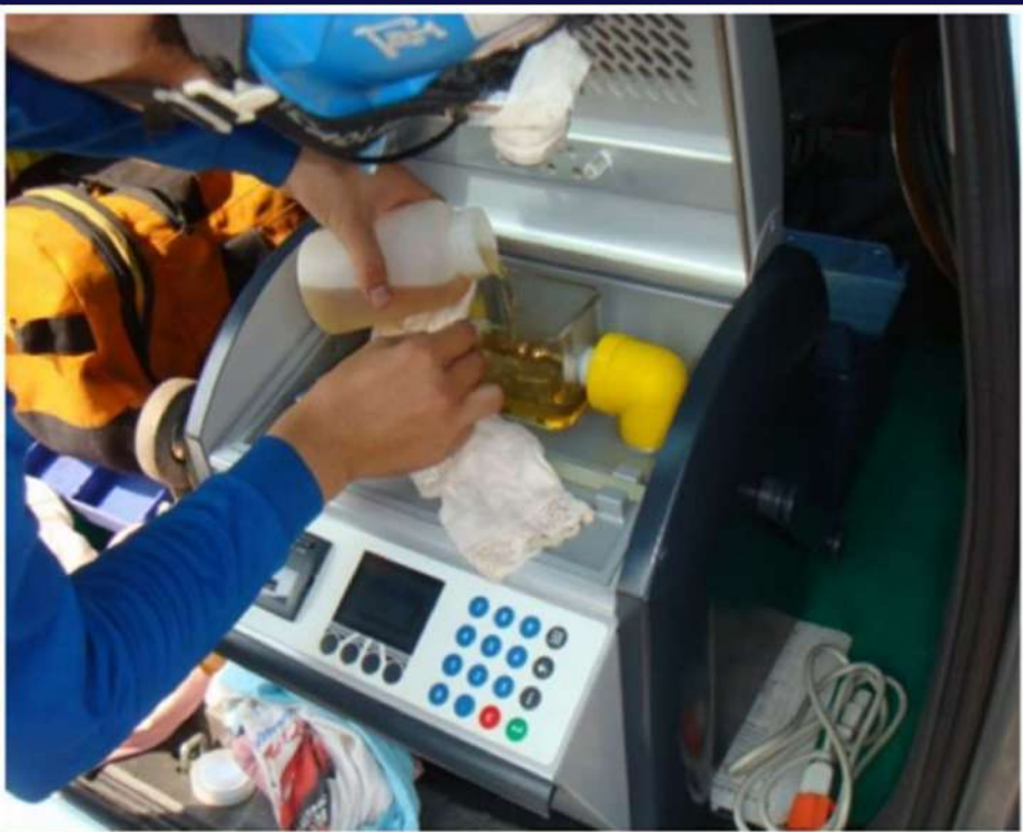
變壓器絕緣油量測
