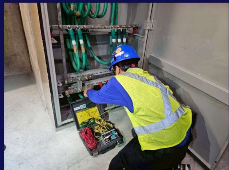
接地系統接地電阻量測
