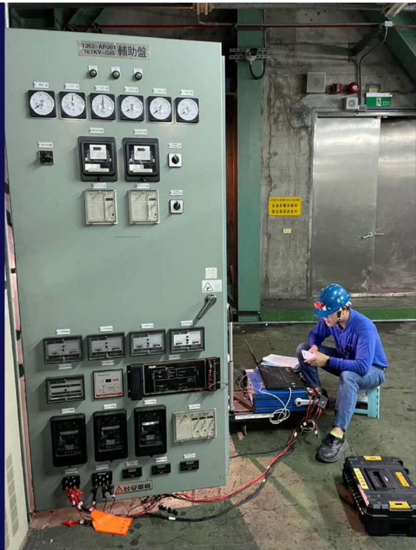
○ 盤保護電驛測試
