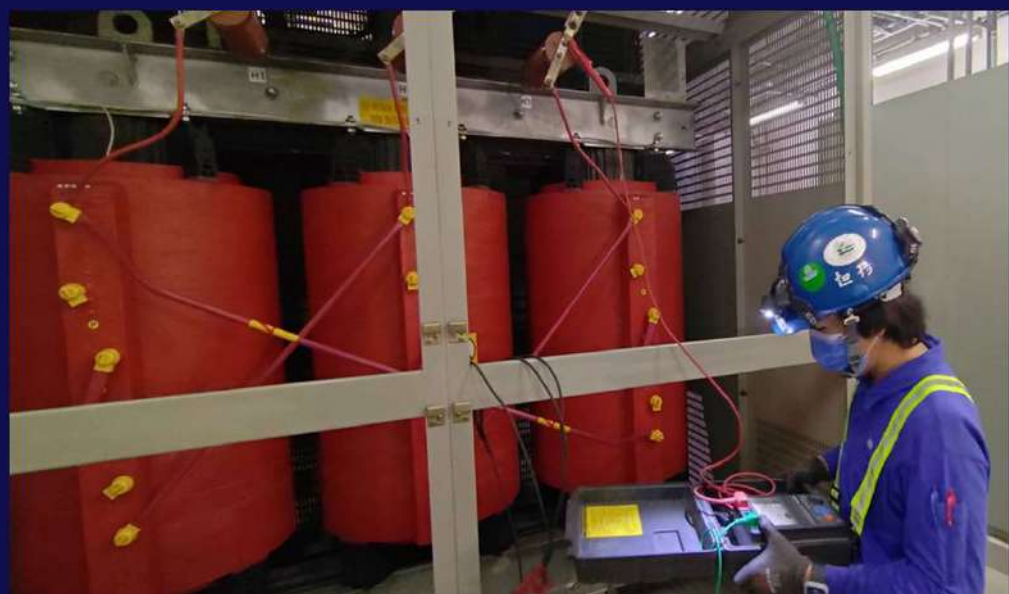
變壓器絕緣電阻量測
