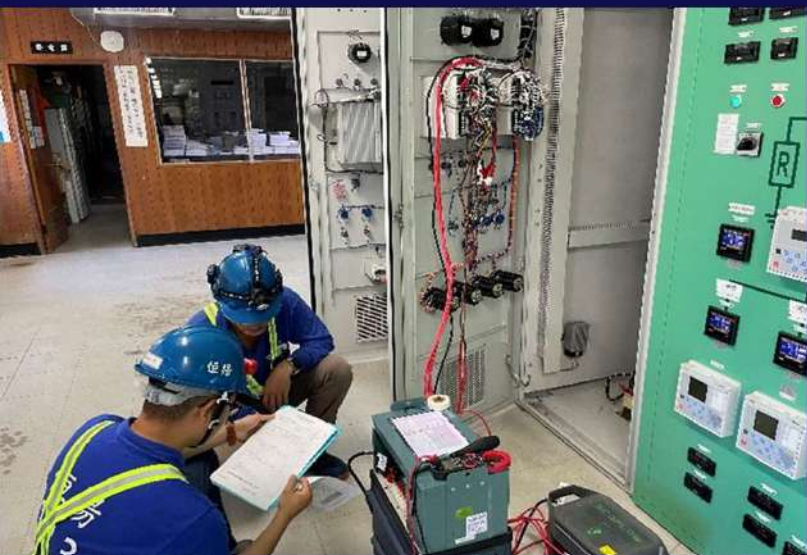
發電廠發電機保護電驛測試
