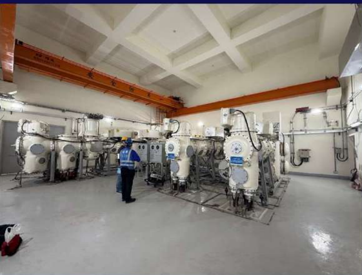
.) 9 氣體取樣測試 含水量 純度 壓力
