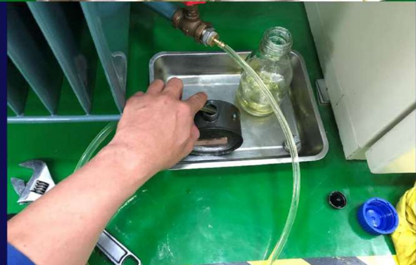
變壓器取油送驗 油中氣體及油品分析
