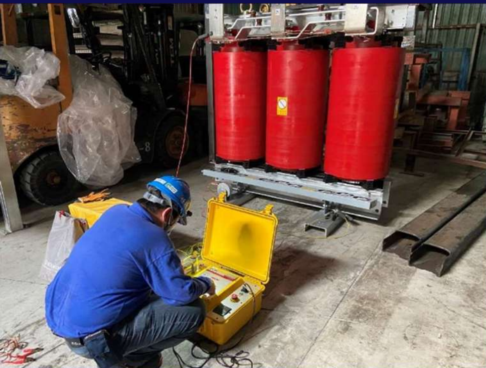
變壓器 電力因數量測
